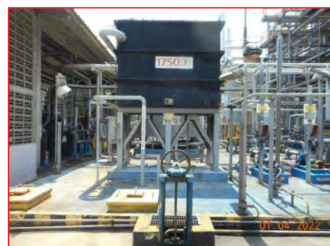
ภาพที่ 2.2-7 บ่อพักน้ำเสีย CPI (SRU)
