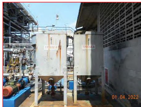
ภาพที่ 2.2-30 Slop Oil Tank เพื่อรวมคราบน้ำมัน จากบ่อกักน้ำเสีย CPI/IAF
