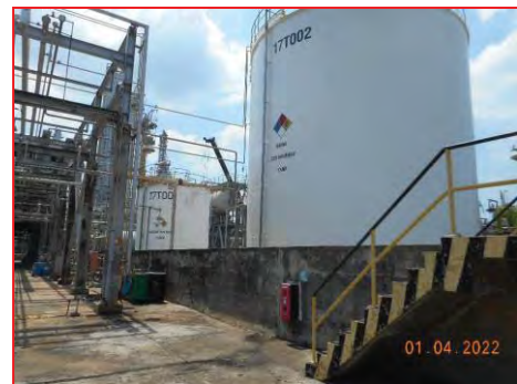
ภาพที่ 2.2-49 คั่นคอนกรีตรอบถังเก็บวัตถุดิบ และผลิตภัณฑ์ (SRU)
