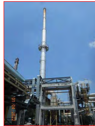
ภาพที่ 2.2-2 ปล่อง SRU1 Incinerator Stack
