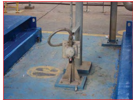
ภาพที่ 2.2-39 H 2 S Gas Detector และ Combustible Gas Detector (ADU)
