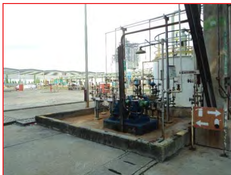
ภาพที่ 2.2-48 คั่นคอนกรีตรอบถังเก็บวัตถุดิบ และผลิตภัณฑ์ (ADU)
