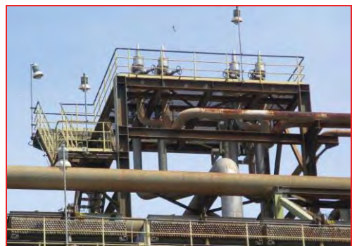
ภาพที่ 2.2-45 ระบบ Double Safety Relief Value
