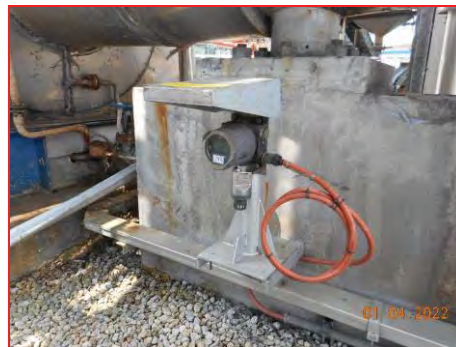
ภาพที่ 2.2-40 H 2 S Gas Detector (SRU)
