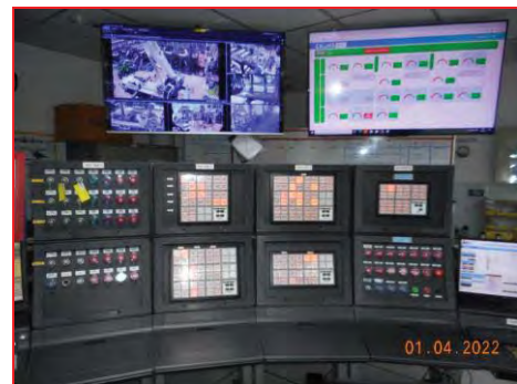
ภาพที่ 2.2-47 ระบบ Inter Lock System (SRU)
