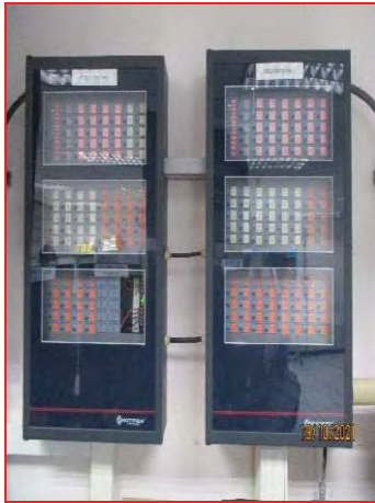
ภาพที่ 2.2-39 H 2 S Gas Detector และ Combustible Gas Detector (ADU)
